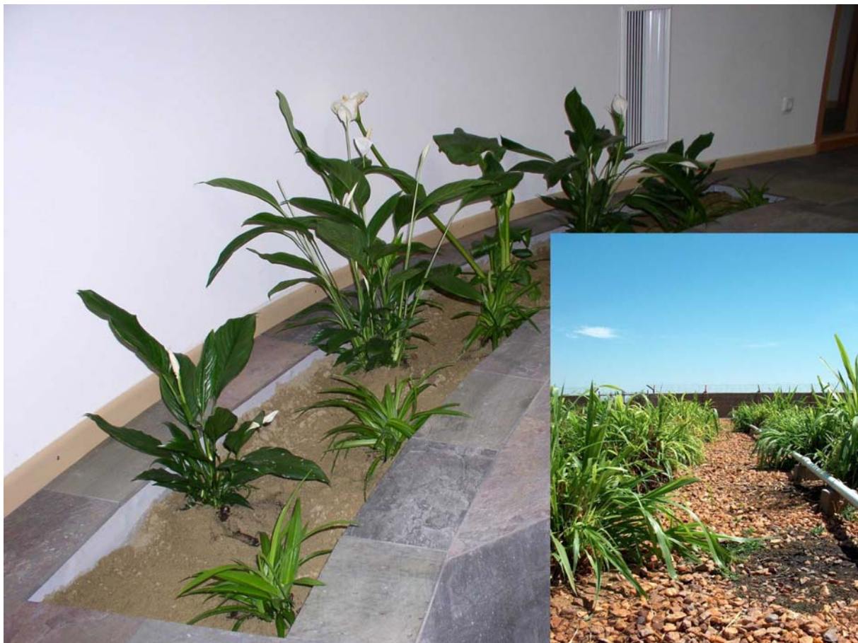
Abbildung 2: bepflanzter Bodenfilter zur Grauwasserbehandlung (Ausschnitt: bepflanzter Bodenfilter in Nordost-Uganda)
